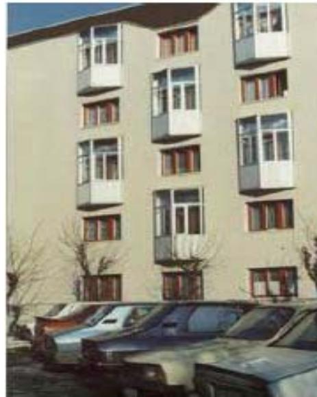
Fig. 2. Foyer T14 Tudor Vladimirescu. Façade isolée avec polystyrène expansée, et POLyALPAN, des bow-windows légers pour valorifier l'effet de serre. Les autres fenêtres ont 3 vitres.
